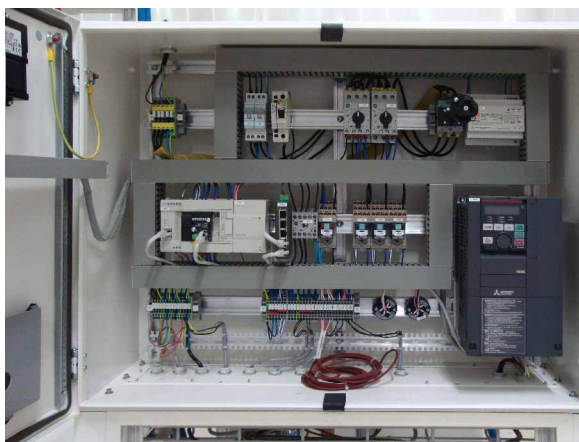
Abb.3 Elektroschrank mit SPS
