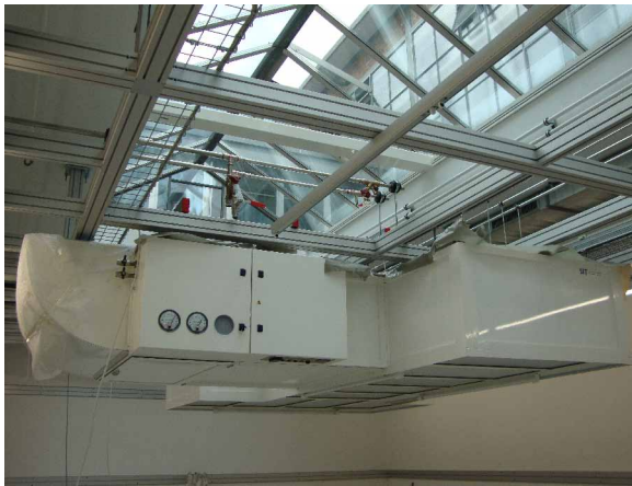
Abb. 1 Aufhängen an bestehende Konstruktion
